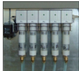
Sensores de presión de aire por radio, sensores 1x Pm, 4x Pz con alarma
